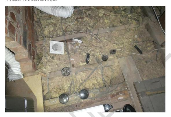
ORIGINAL CEILING BINDERS SPANNING FRONT TO REAR AND ORIGINAL JOISTS SPANNING SIDE TO SIDE.
